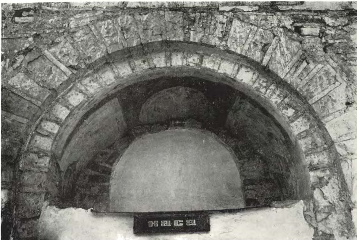
Niche with plaster removed — southern façade. Очищена від тинку ніша південної фасади.
